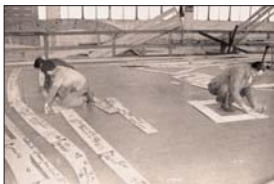
Die Herstellung der Schablonen für das Handelsschiff Jeanne-Schiaffano im Anreißersaal der Werft Dubigeon im Jahre 1955.
