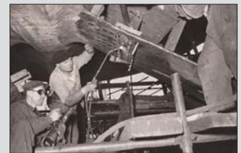
Eine Mannschaft von Vernietern bei der Arbeit am Geleitschiff Guépratte , das 1956 in der Werft ACB gebaut wurde.
