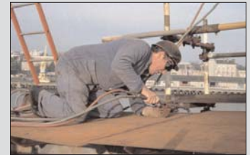
Ein Verschneider bei der Anpassung einer Naht an Bord eines im Bau befindlichen Schiffes.
